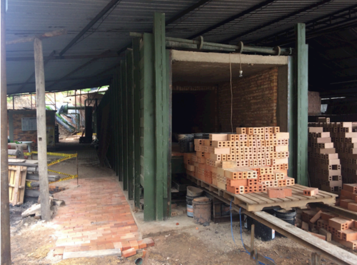
Productores en Sogamoso, Colombia invierten en pequeño horno túnel, reduciendo contaminación y aumentando productividad. Fue acompañado de política de prohibición de hornos más contaminantes, de asistencia técnica para quienes desearan invertir en nuevas tecnologías, y de la compra de producción de un año y asistencia laboral para traspaso a otras actividades productivas para productores que preferían cambiar de actividad. Foto: JDTaillant.
