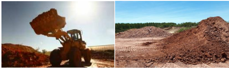
Foto 11 - extracción de arcilla
